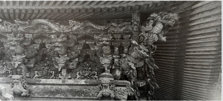
▲図10 戦災焼失前に撮影された台徳院殿靈廟本殿二層目の組物
