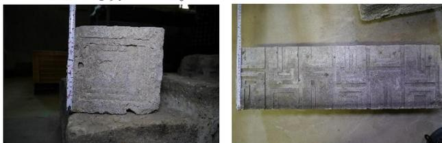
図3 解体材料の大谷石 (左) と復原材料の大谷石風 GRC (右)
